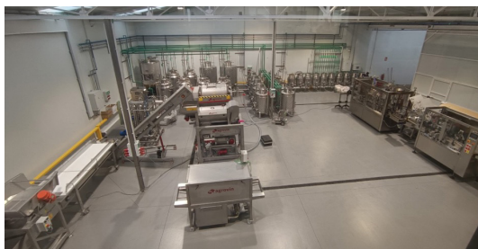
Εικόνα 3: Η εγκατάσταση της μονάδας SMARTWINERY
